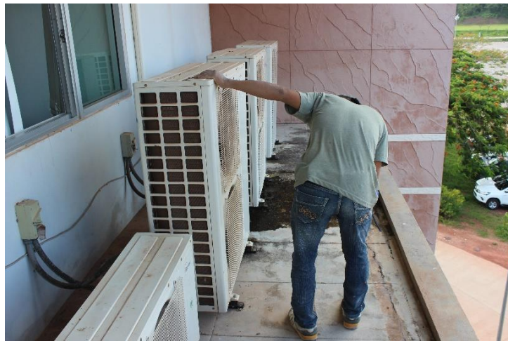
ภาพการตรวจสอบสภาพก่อนล้างเครื่องปรับอากาศ
